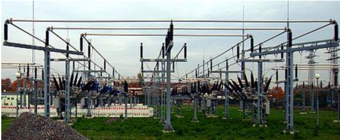
Figure2.10 :les jeux de barres
