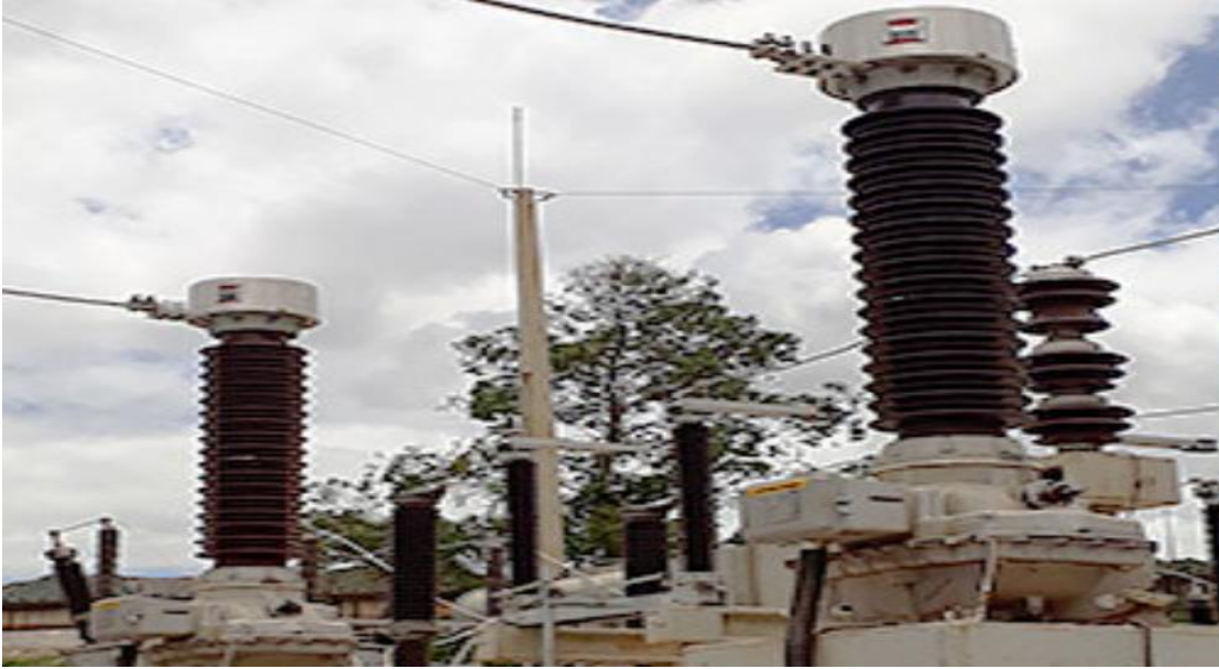
Figure2.6 : transformateur de tension
