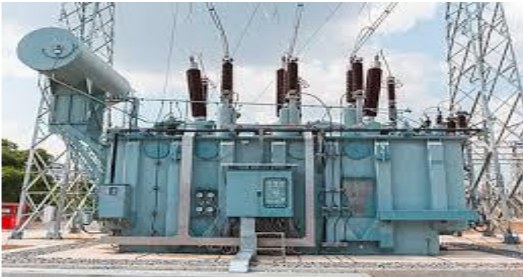
Figure2.5 : transformateur de puissance
