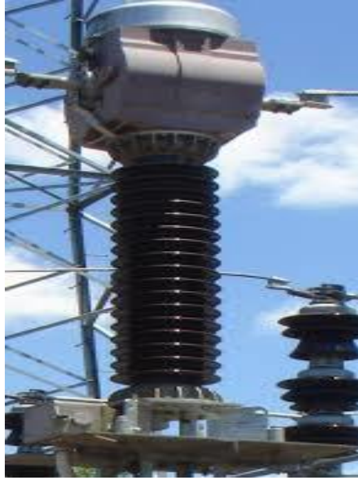
Figure2.7 : transformateur de courant
