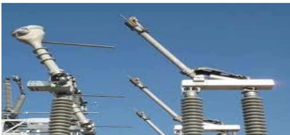
Figure2.8 : Le sectionneur
