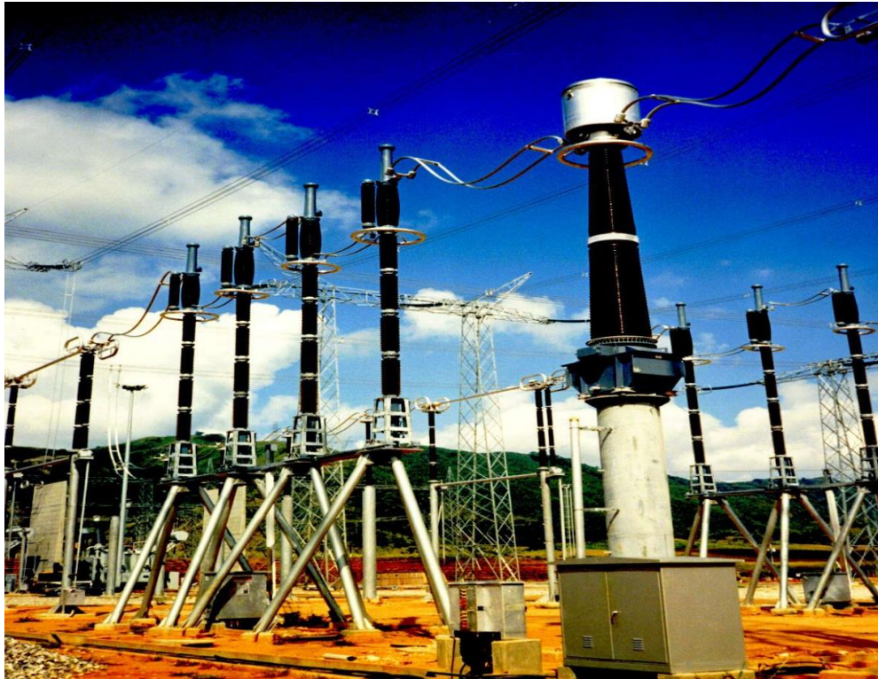
Figure2.8 : Disjoncteur haute tension
