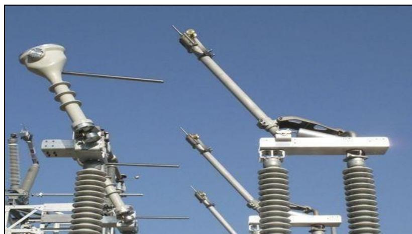
**Fig1.16:** Le sectionneur
