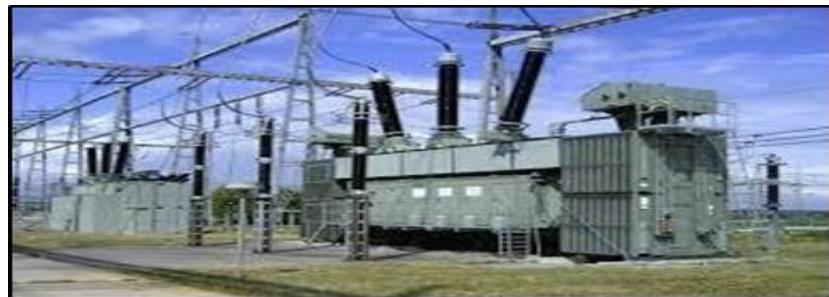
**Fig1.12:** transformateur de puissance
