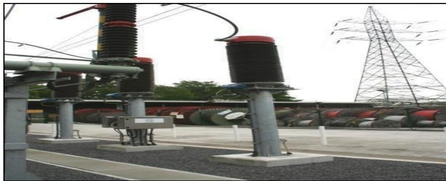
**Fig1.13:** transformateur de tension
