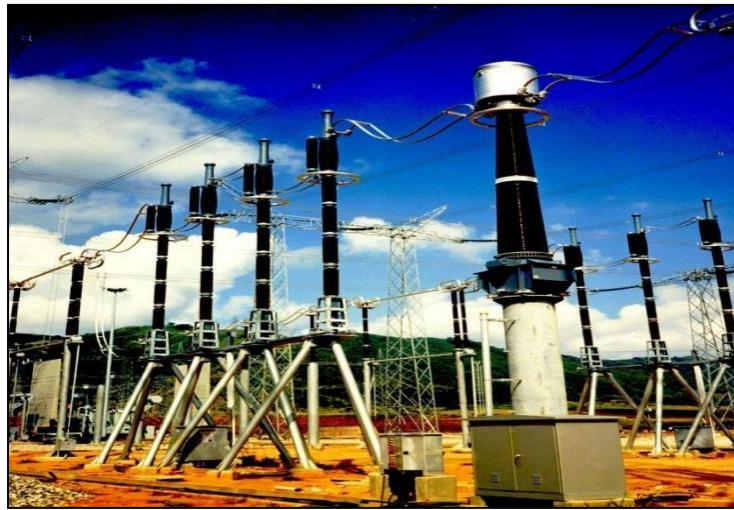
**Fig1.15:** Disjoncteur à haute tension
