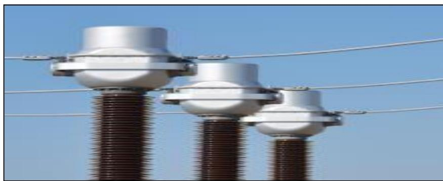
**Fig1.14:** transformateur de courant
