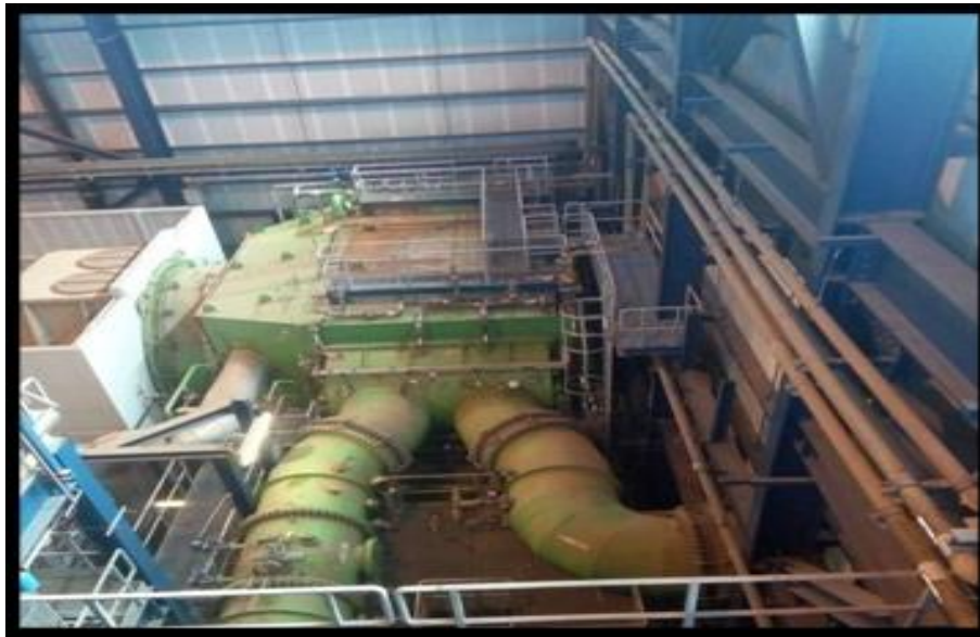
Figure 6 : Photo réelle du condenseur.
