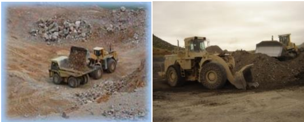
Figure I.3 : Transport et décharge de calcaire et argile.
