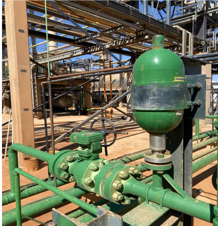
Figure IV.4 : Accumulateur à vessie
