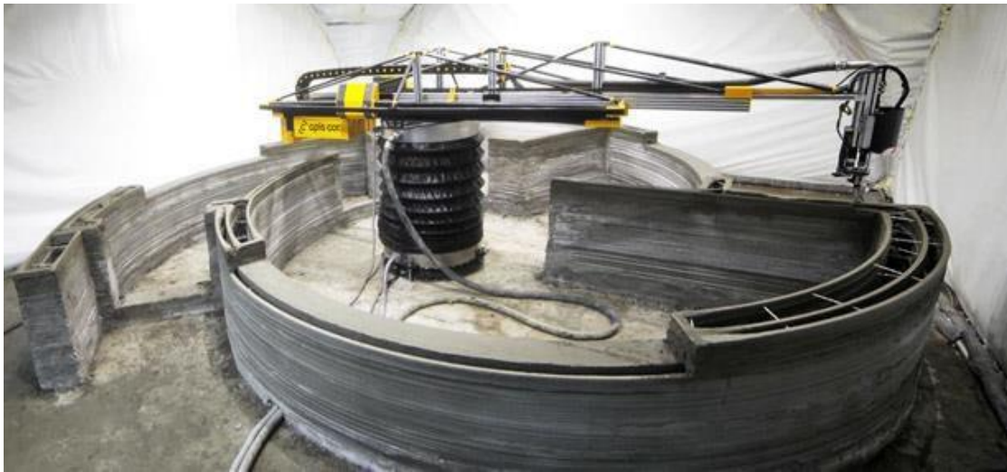
Figure II.04: Imprimer une maison avec un bras robotisé
