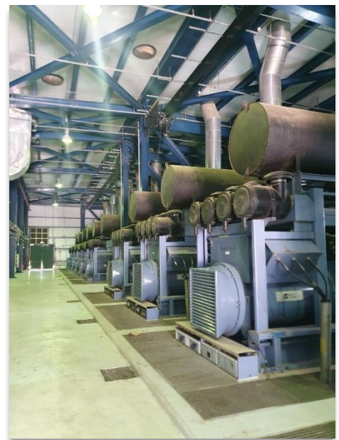
Figure I.16 Système black start.[24]
