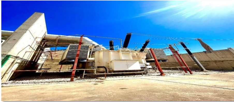
Figure I.13 Vue du transformateur de groupe.
