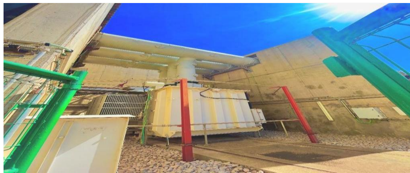
Figure I.14 Vue du transformateur de soutirage.
