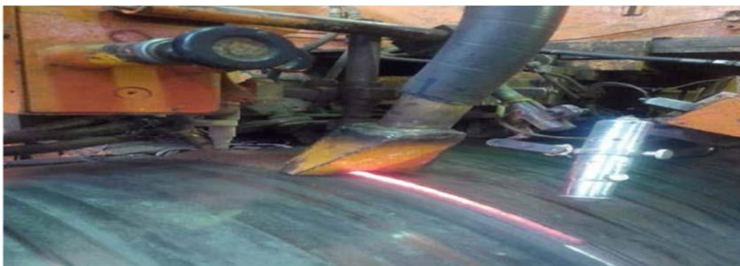
Fig I.9 : Weld bead
