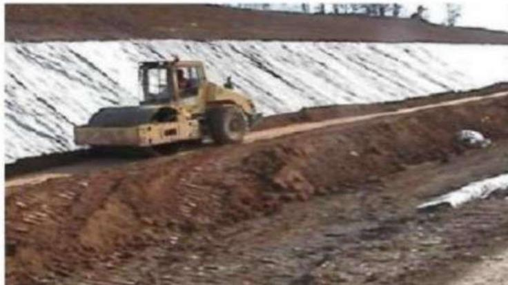
**Figure 45 : L'utilisation du géotextile en jouant un double rôle le drainage et le renforcement du talus. (BERRABAH, 2010)**
