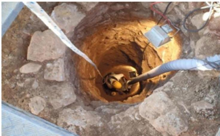
**Figure I.5 :** fouilles en puits
