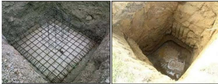
**Figure I.2 :** fouille isolée
