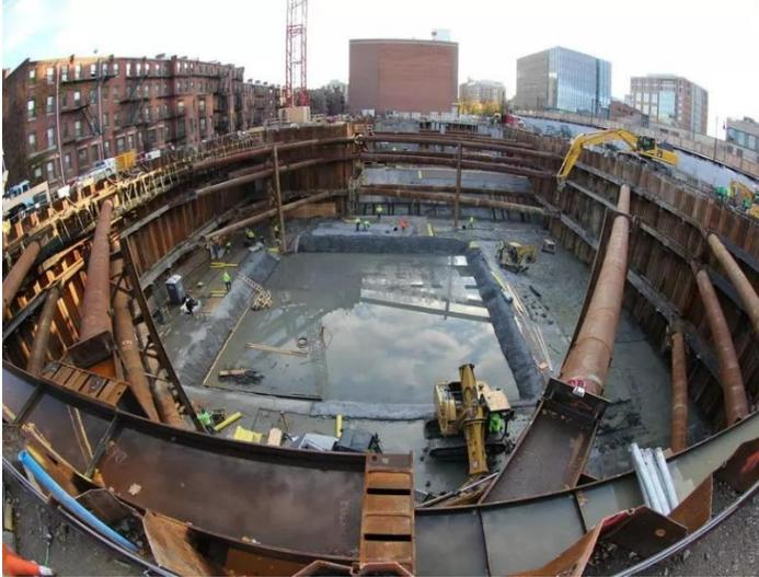
**Figure II-6 :** palplanche métallique
