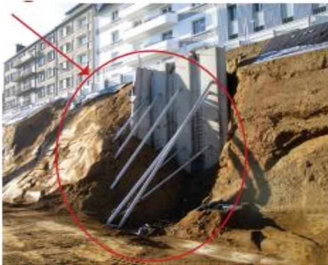
**Figure II.1 :** éboulement et blindage provisoire
