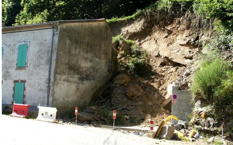
**Figure I.8 :** glissement de terrain
