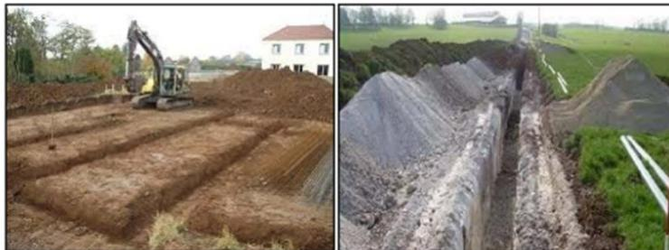
**Figure I.3 :** fouilles en rigole et en tranchée
