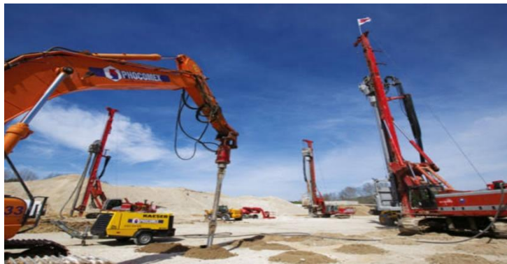
Figure.1.9 : Vibrocompactage.
