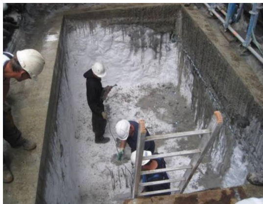
Figure.1.11 : Travaux en souterrain : la congélation des sols.
