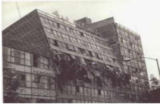
**Figure 28: Exemple de dommage dû à l'irrégularité en élévation (Variation des**
