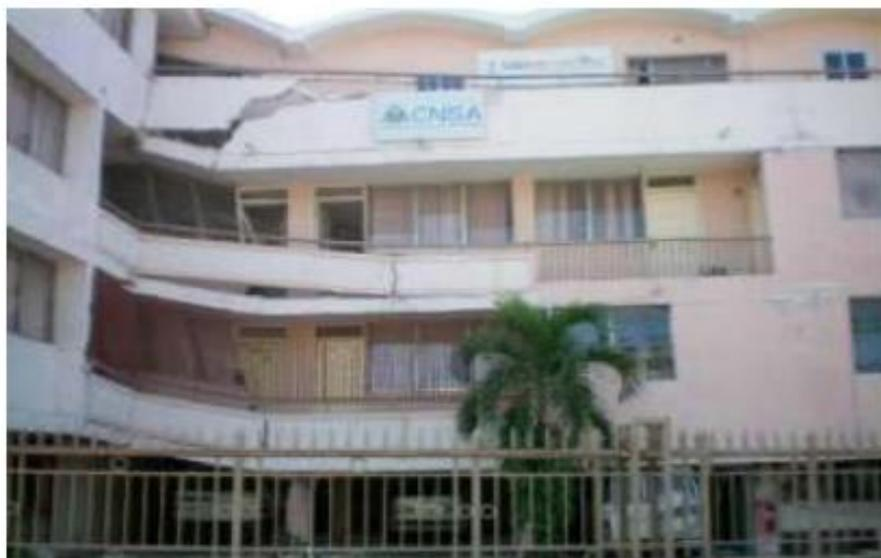
Figure 25: Exemple de dommage dû à l'irrégularité de forme
