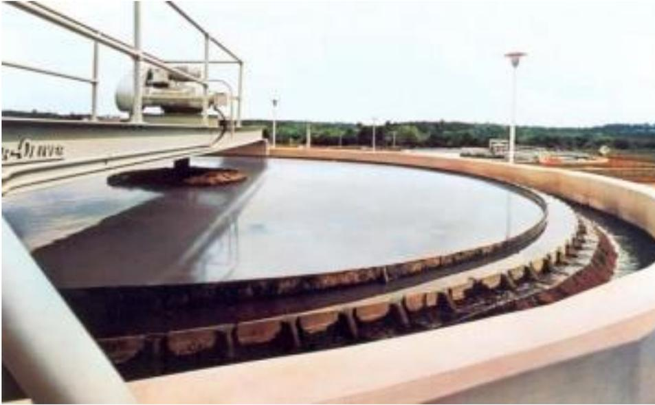
**Figure II.2 :** Décanteur de l'unité CFL du complexe sidérurgique d'El Hadjar.
