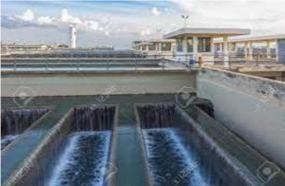
**Figure II.3:** filtre à sable
