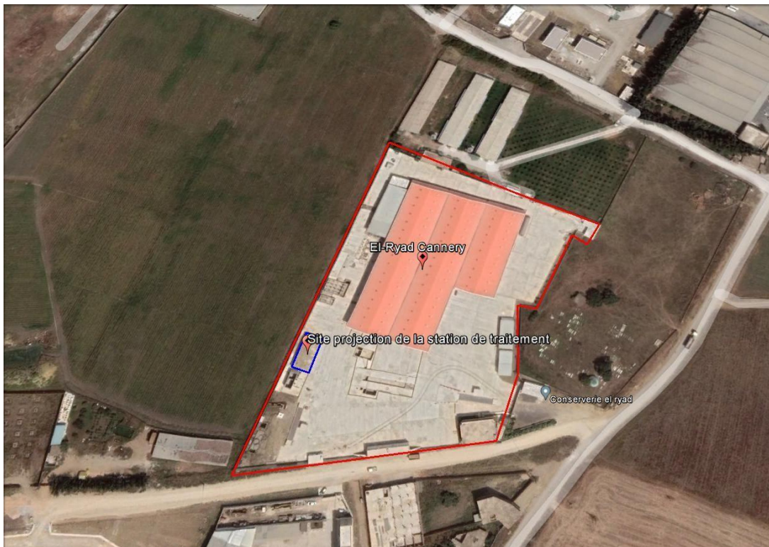
Figure III.1 : Station de Traitement des eaux pour conserverie El- Ryad
