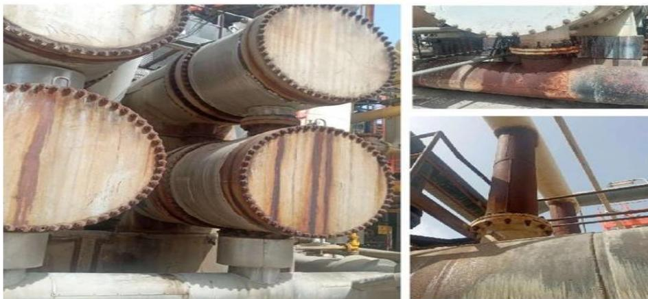
**Figure IV.1 :** Corrosion des échangeurs de Fertil Annaba.
