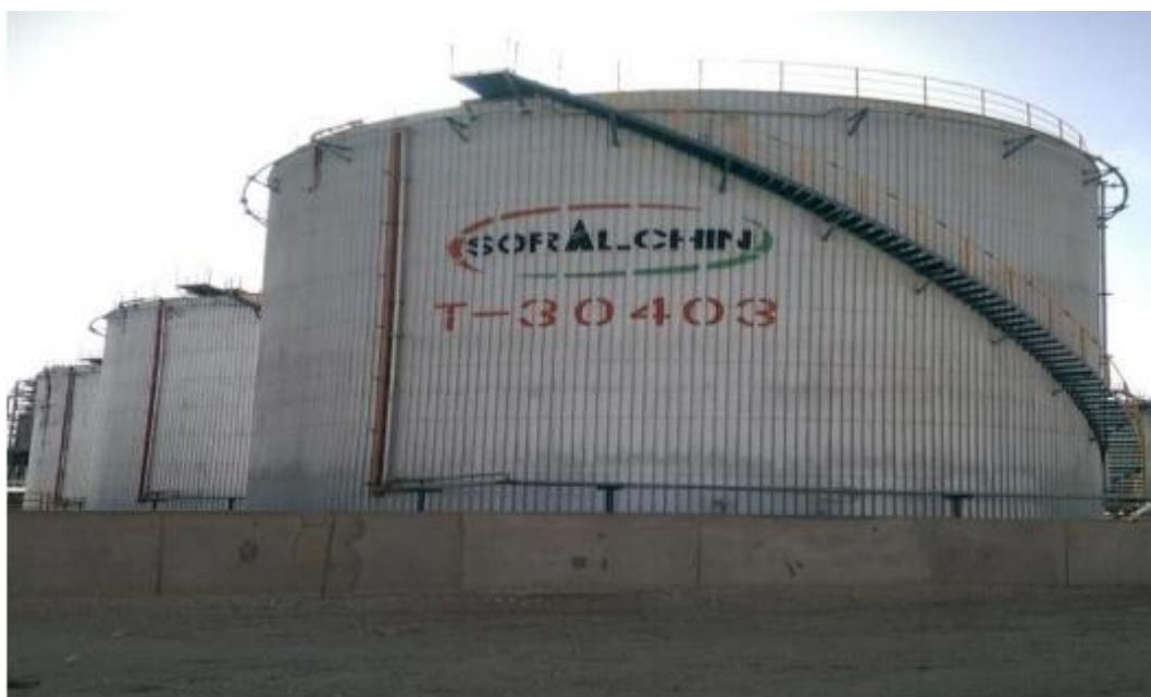
**Figure II.6** : Bac de stockage de résidu.
