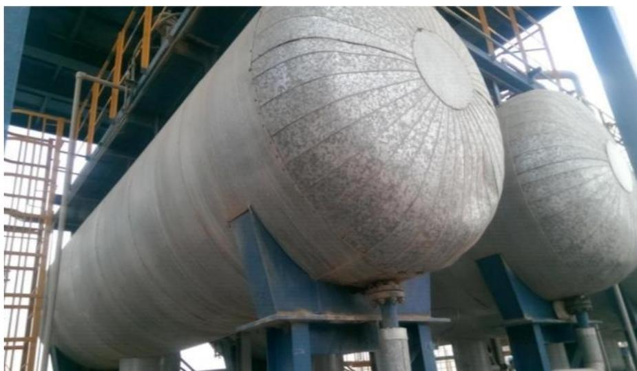
**Figure II.7** : Ballon de reflux.
