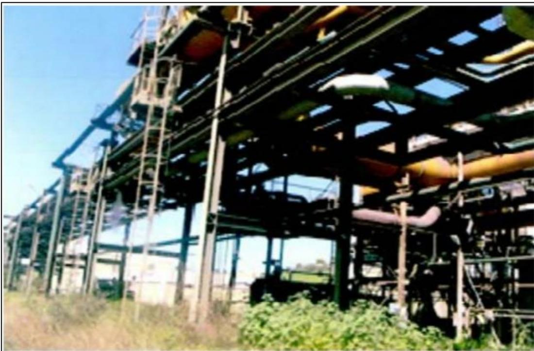
*Figure I- 4: Rack conduite (vapeur-gaz-eau-air)*
