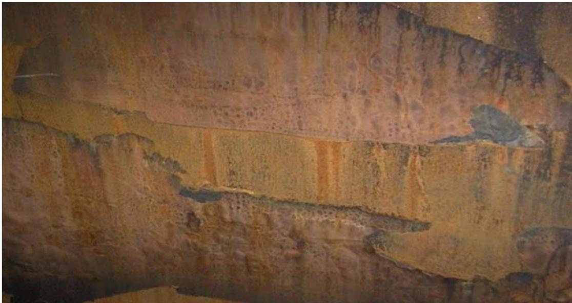
**Figure IV.1.** Corrosion sévère à l'intérieur de la colonne d'absorption.
