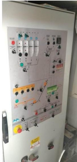
**Figure 4.6 – Panneau de commande de la centrale à béton**
