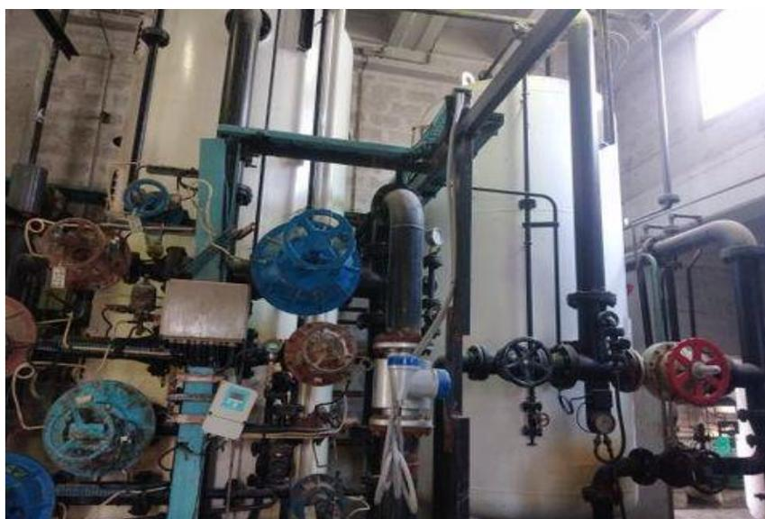
Figure I.5. Chaîne de production d'eau déminérée.
