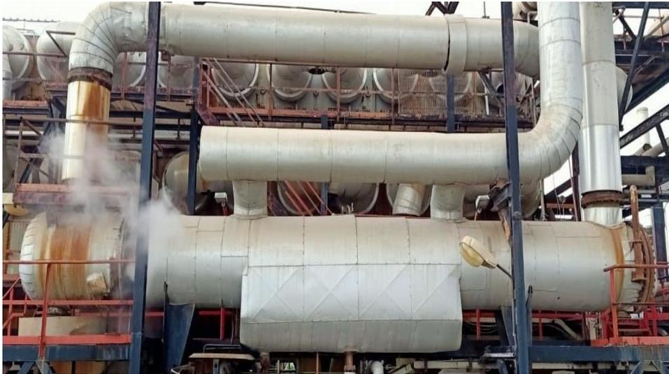
Figure II.13- Réchauffeur de la section de dessalement
