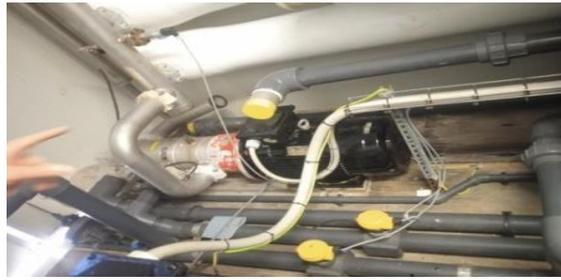
**Figure (III.13):** La pompe à haute pression
