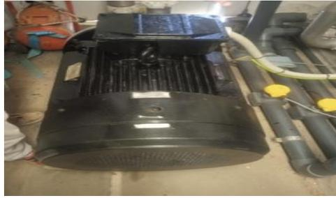
**Figure (III.14):** La Pompe de récupération d'énergie.
