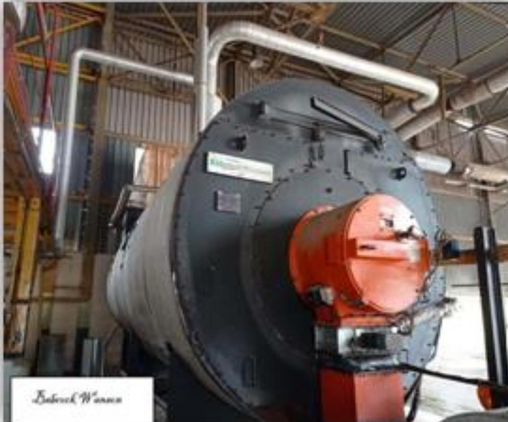
**Fig 3. 2-La chaudière Babcock Wanson de la zone fluide**
