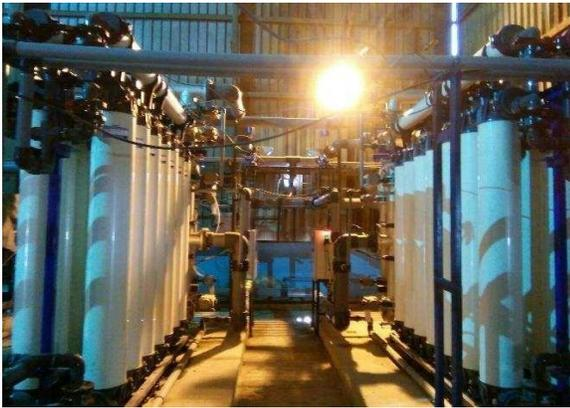
Fig 5. 4-Installation d'ultrafiltration-Zone
