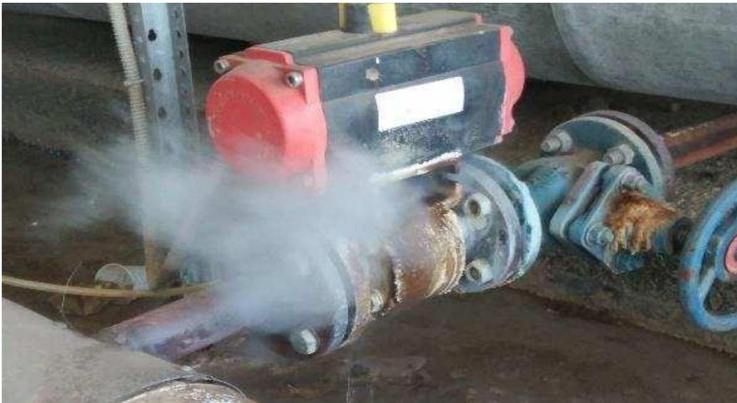
**Fig 5. 1-Capture de fuite au niveau de la chaudière**
