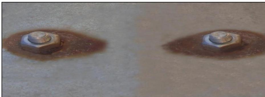
Fig 4. 5-Effet d'une corrosion galvanique
