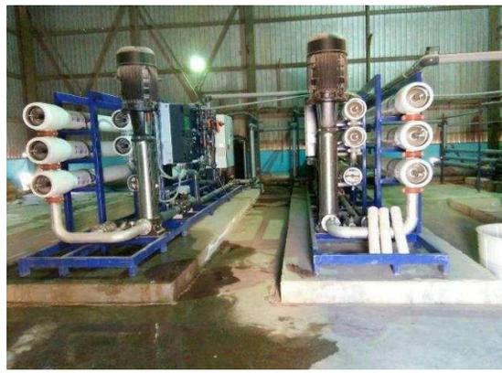
Fig 5. 5- Installation d'osmose inverse-Zone
