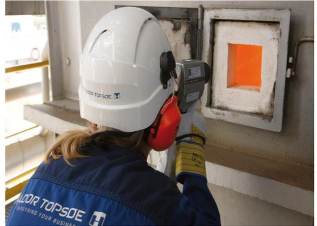
**Figure I.22 :** Contrôle de la température des tubes catalytiques
