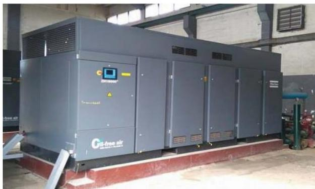
**Figure I.8 :** compresseur ATLAS COPCO à trois étages
