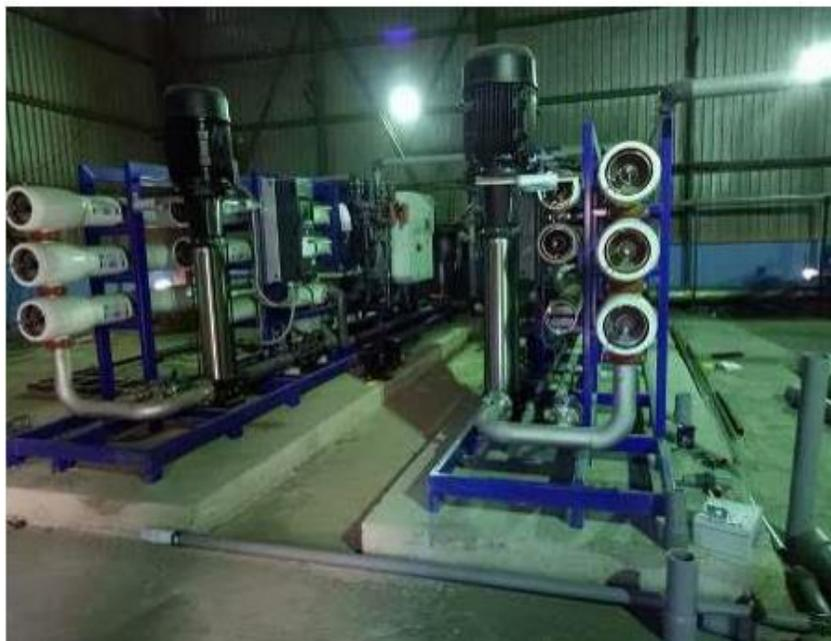
**Figure II.15 :** l'installation de l'osmose inverse dans la zone EST
