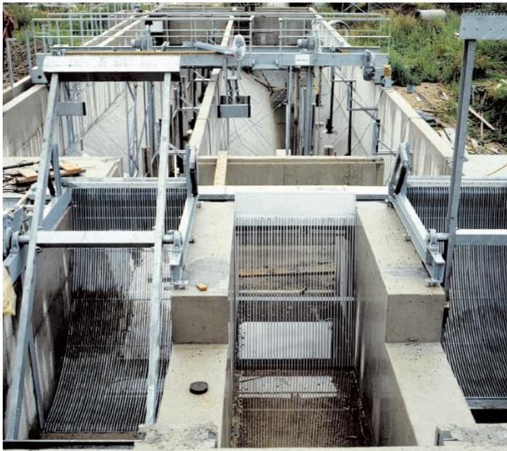
**Figure II.1 : le dégrilleur**
