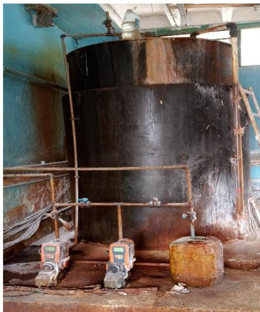
**Figure II.4 :** le bac de coagulant ( $Fe Cl_3$ )
