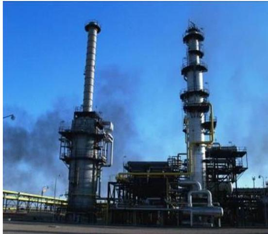
**Figure I- 12:** Colonne de Stabilisation et Rebouilleur [3]
