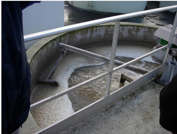
Figure II.3 : Le dégraissage
