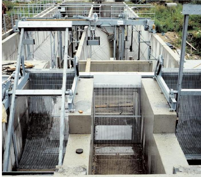
**Figure II.1 : le dégrilleur**
