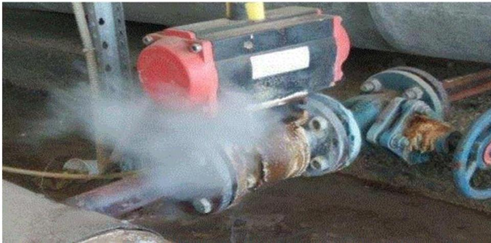
**Figure IV.1** : Capture de fuite au niveau de la chaudière
