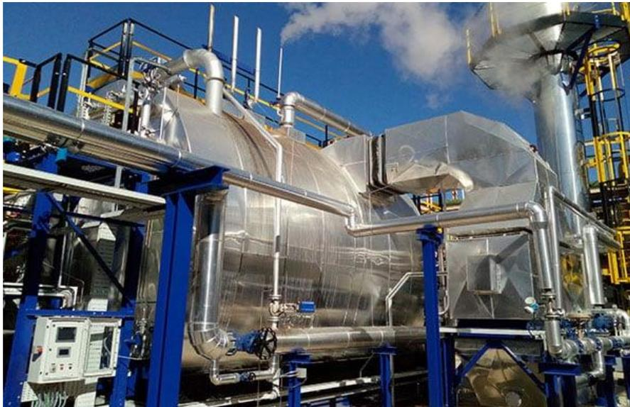
Figure III-2 : chaudière a tube d'eau
