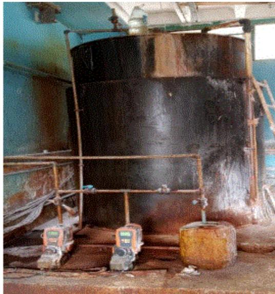
**Figure II.4** : le bac de coagulant ( $FeCl_3$ )
