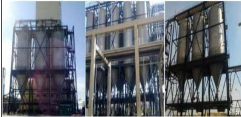
**Figure II.13 :** les silos de stockage de la poudre, granulé
