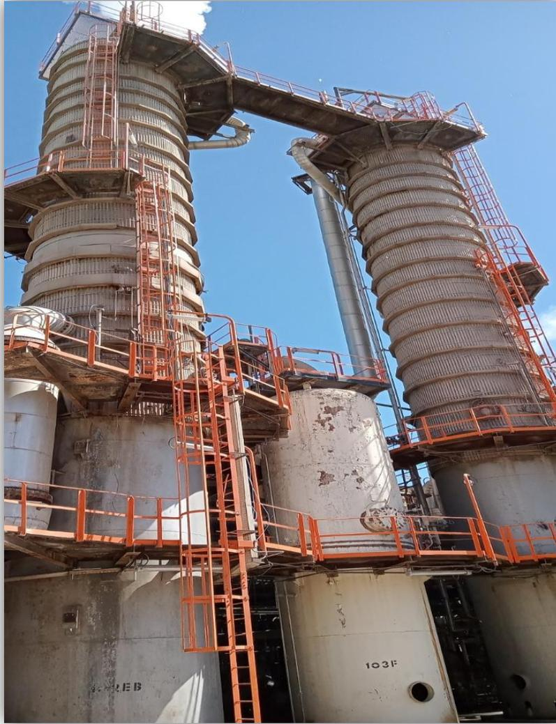
**Figure IV.4:** deux colonnes de régénération (102-EA/B).
