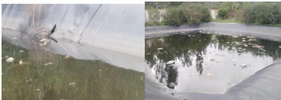
**Figure II.25 :** Bassins de sédimentation du centre d'enfouissement technique de Smati
