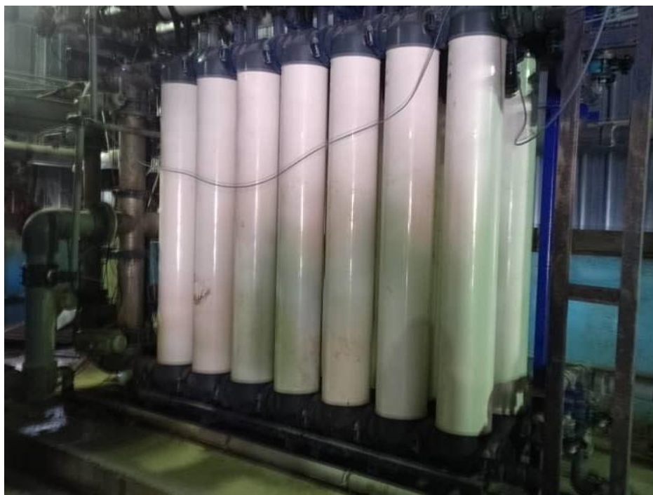
Figure II.12. L'installation d'ultrafiltration à SIDER.
