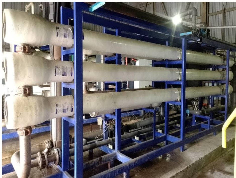
Figure II.14. L'installation d'Osmose Inverse à SIDER.
