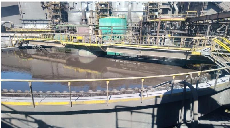
Figure 14 : pour la séparation de partie de boue fine à partir de coagulation et floculation.
