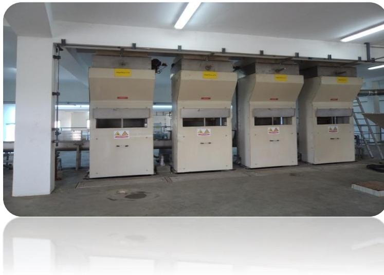
**Figure I.2 : Dégrilleur**
