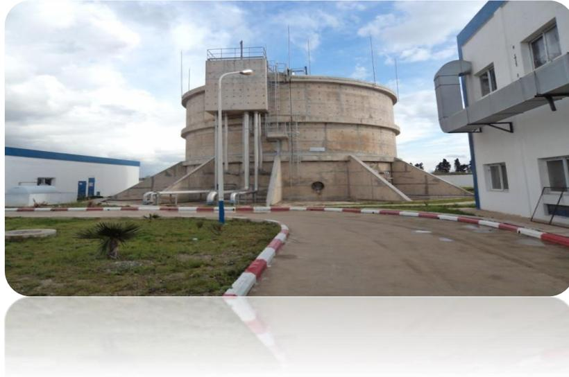
**Figure I.9 : Digesteur**
