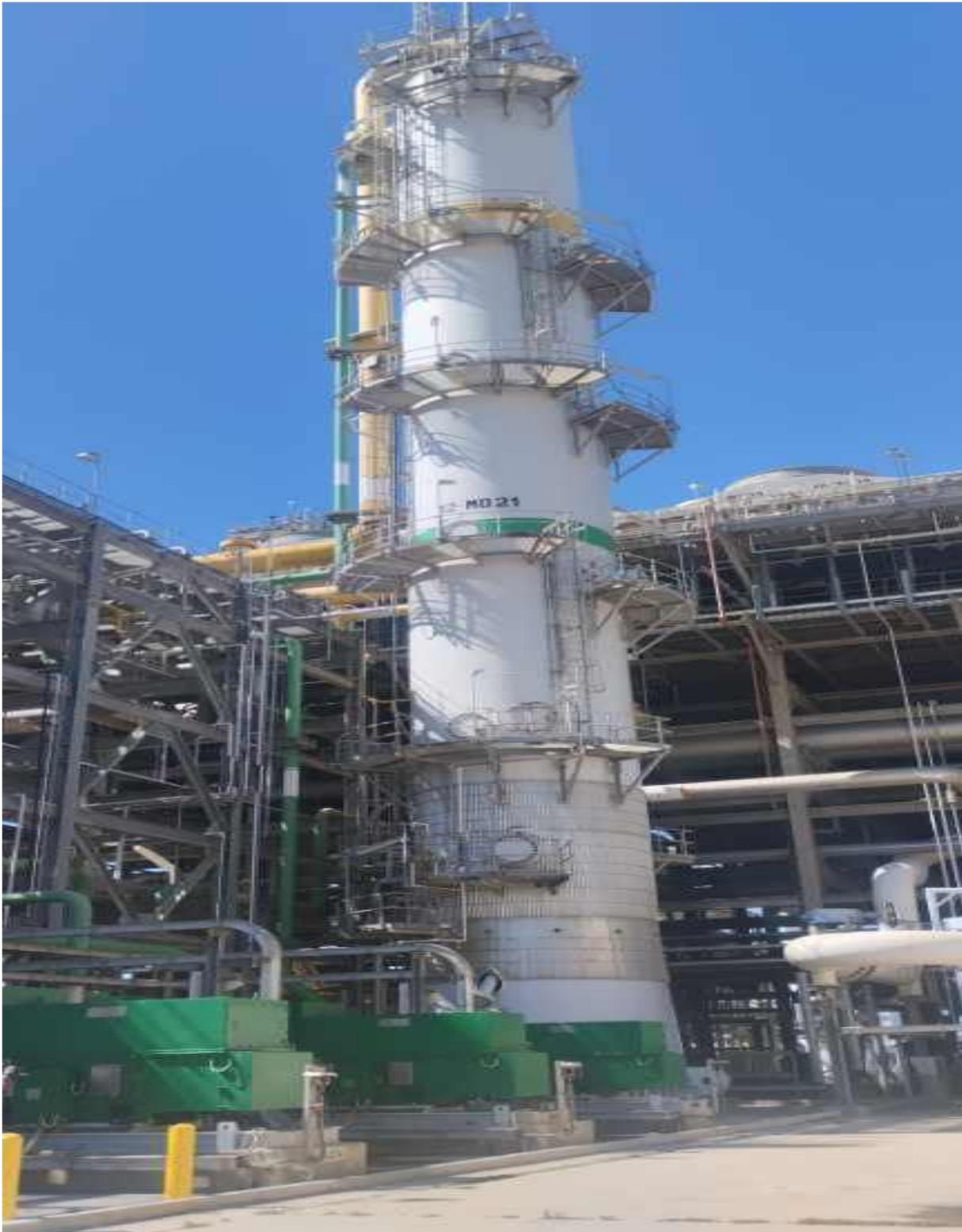
Figure II.8 : Colonne de décarbonatation dans le complexe de GNLK de Skikda
