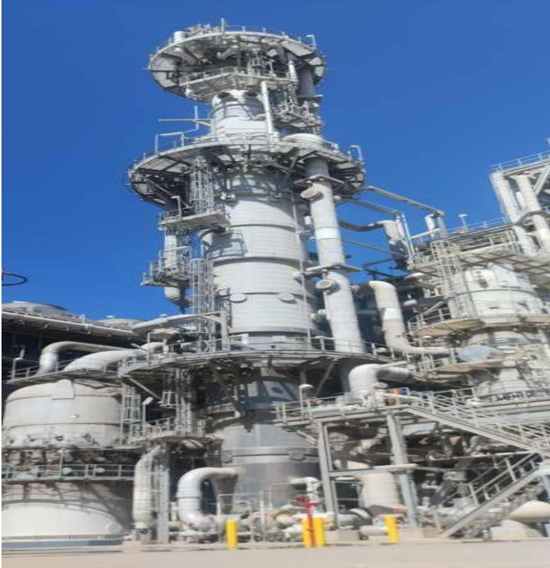
**Figure II.10 :** Echangeur cryogénique de GNL dans le complexe de GNL01K de SKIKDA
