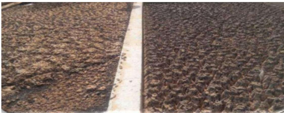
**Figure II .4 :** Un lit de séchage.
