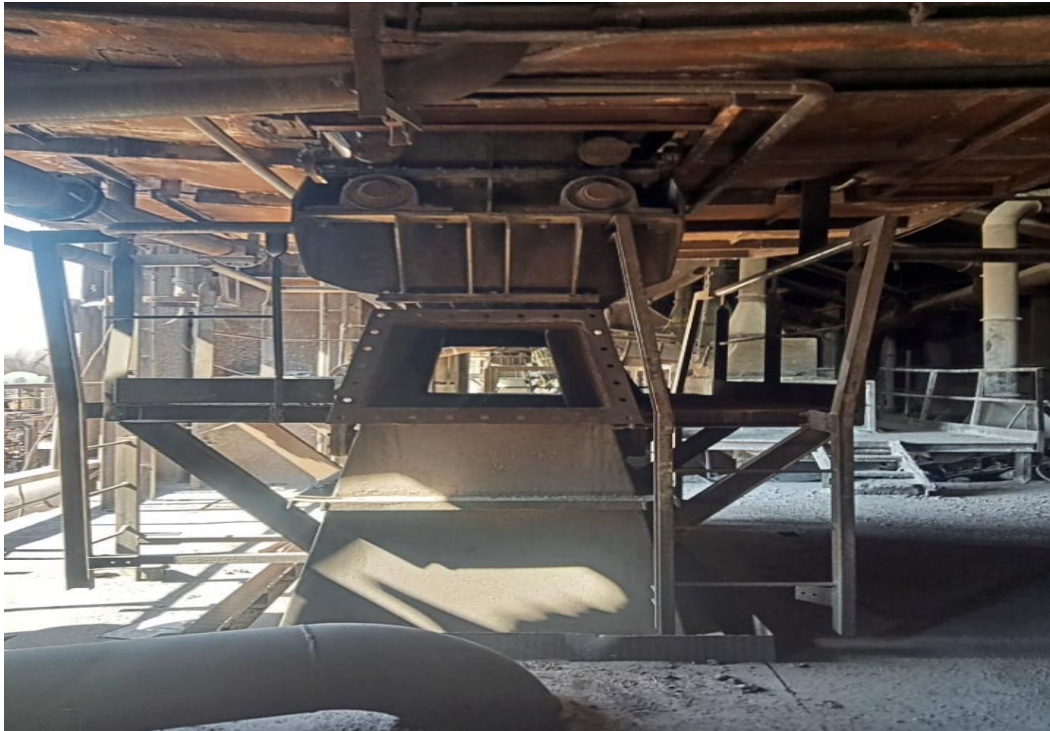
Figure.II.2 : Absorbeur venturi
