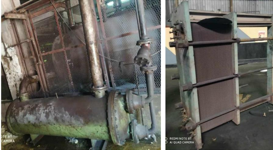
**Figure 24.** L'échangeur tubulaire et la bobine de l'échangeur à plaques du complexe Sider El Hadjar
