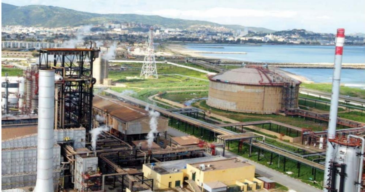
Figure 1: photo vue du usine Fertial Annaba.
