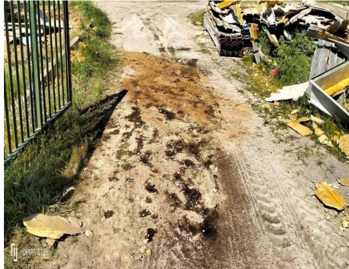
Figure 21: Neutralisation d'un déversement avec le sable
