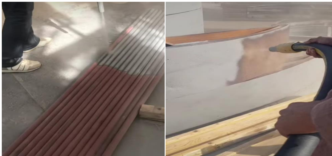
Figure 22: Enlever la rouille avec le sable
