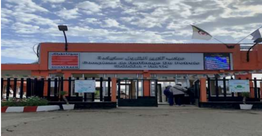
Figure I.1 : L'entrée du complexe de raffinage du pétrole Skikda - RA1K
