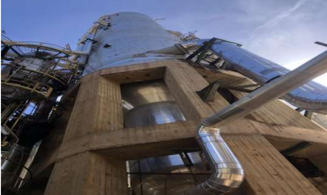
Figure I.6 : Colonne de distillation atmosphérique.
