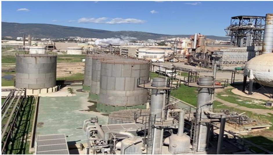
**Figure III.2 :** les 4 bacs de stockage d'acide nitrique avec les 3 pompes d'alimentation
