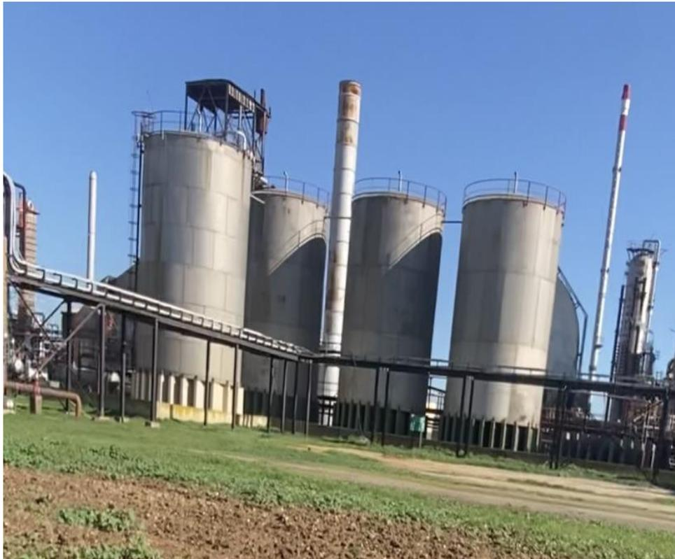
**Figure. III. 01:** les 4 bacs de stockage d'acide nitrique.
