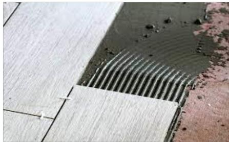
**Figure I.4** : mortier colle : exemple d'application
