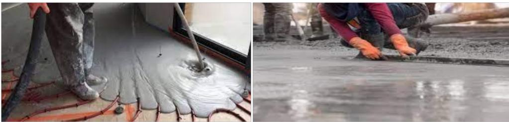
**Figure I.7** : mortier de ciment utilisé pour réaliser une chape
