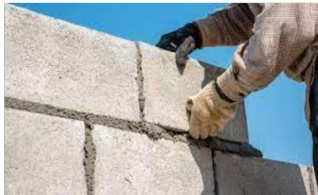
Figure I.5 : mortier de ciment utilisé pour les joints
