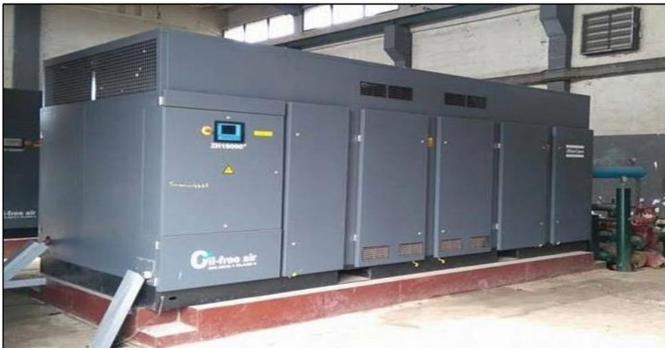
**Figure I.4:** Compresseur copco atlas à trois étages.
