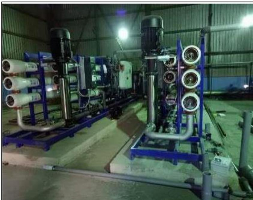
Figure I.18 : l'installation de l'osmose inverse dans la zone EST.
