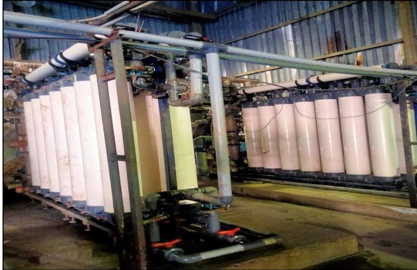
Figure I.15 : Installation D' ultrafiltration .
