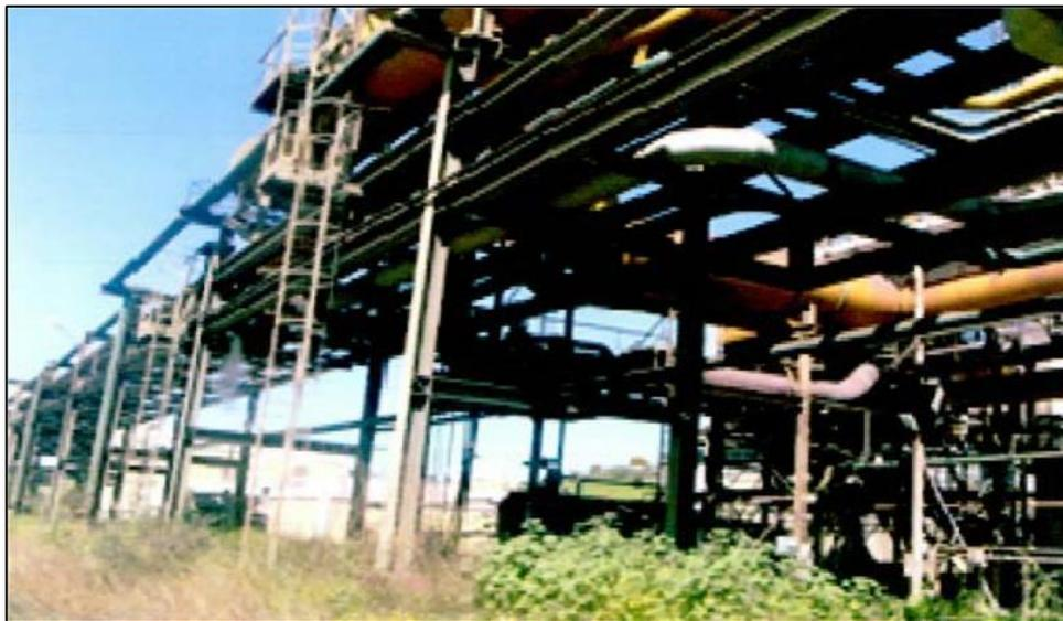
*Figure I.1* : Racks conduites (vapeur – gaz – eau – air).
