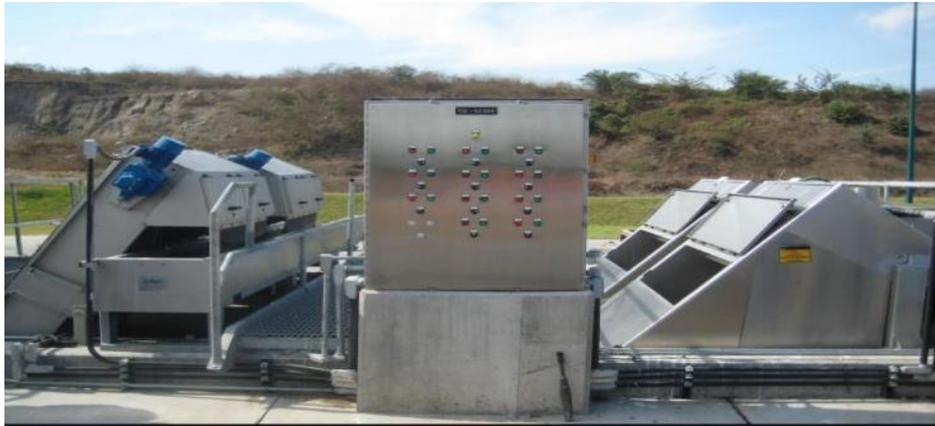
Figure. II.6 : Un dégrilleur.
