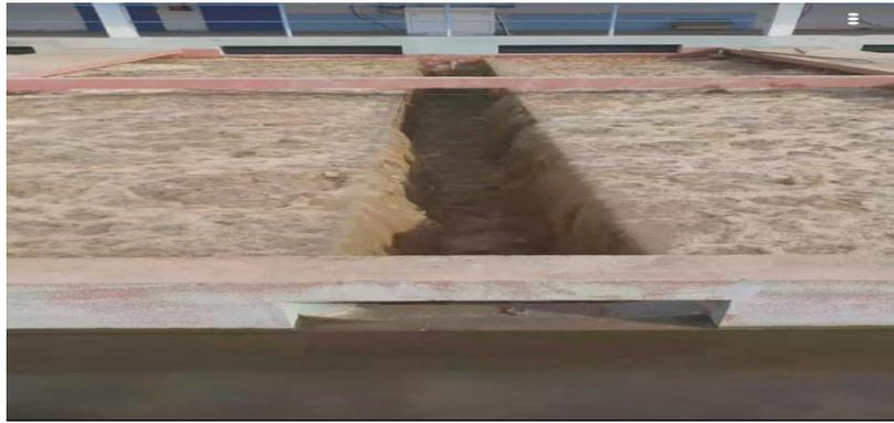
Figure. II.10 : filtration sur sable.
