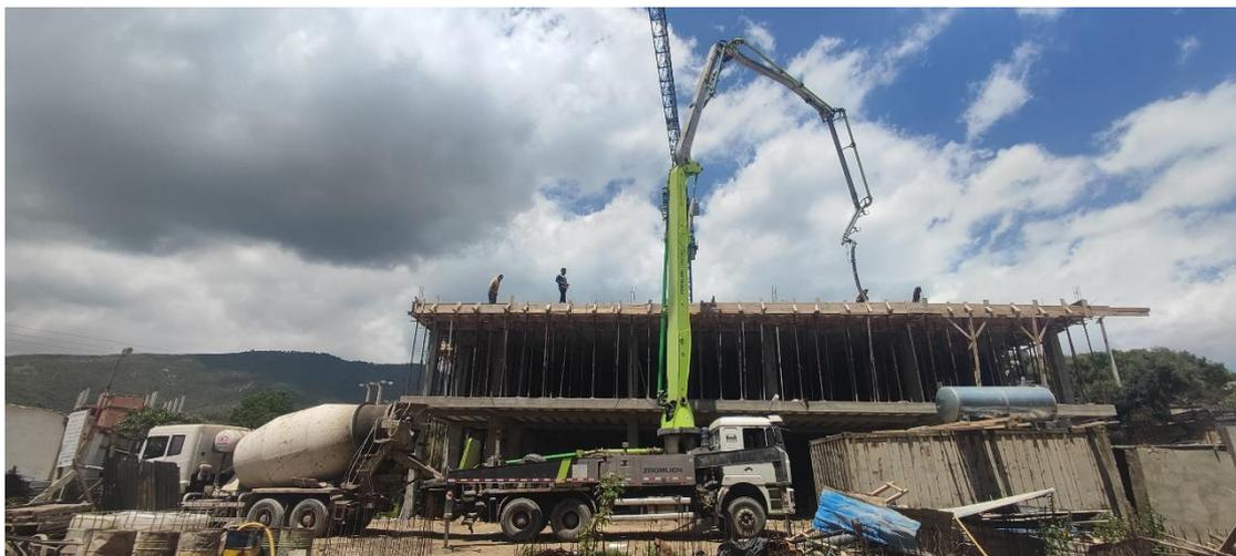
Figure I.10 : Transport et mise en place du béton par pompe girafe.
