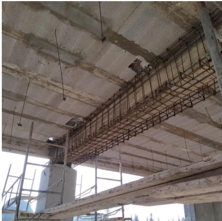
**Figure I.4 :** renforcement de poutres.
