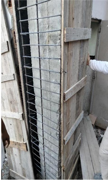
**Figure I.3 :** renforcement de poteau.
