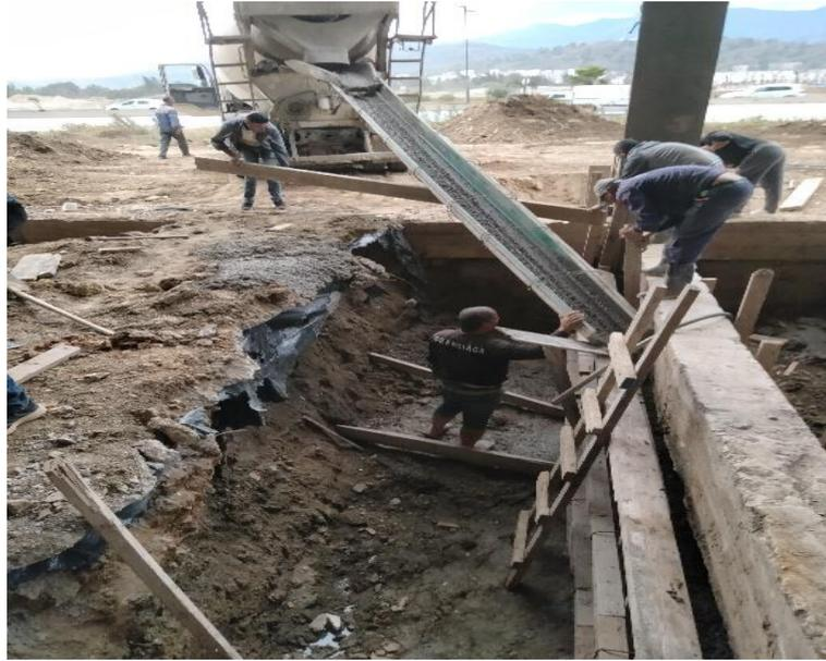
**Figure I.5 :** renforcement des fondations pour mauvaise qualité des bétons
