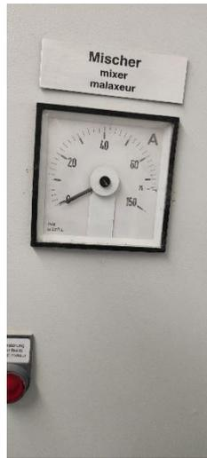
**Figure I.26 :** Ampèremètre de fonctionnement du malaxeur
