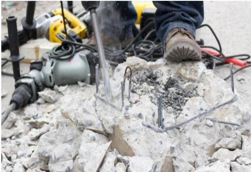
**Figure I.6 :** démolition d'une dalle en béton armé.
