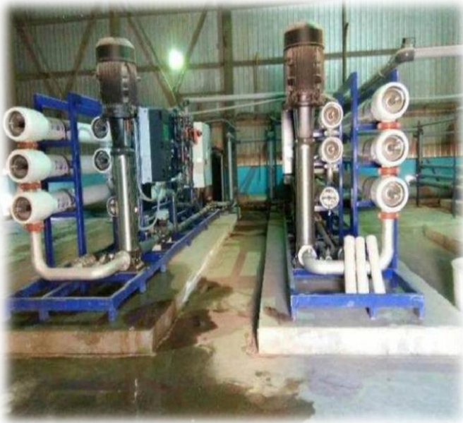
Fig.I.5- Installation d'osmose inverse
