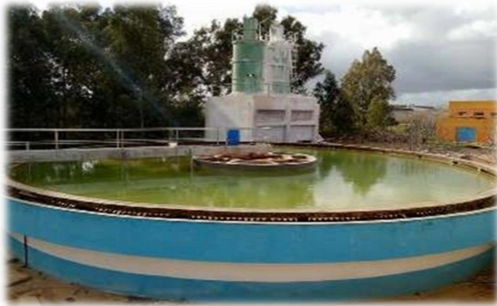
Fig.I.4- Prise de vue du décanteur de la station de traitement des eaux industrielles Zone Est- SIDER [6]
