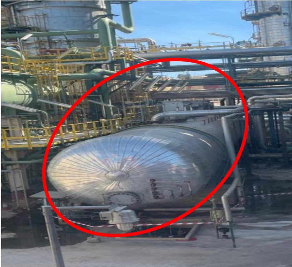
**Figure 06:** Dessaleur électrostatique V51
