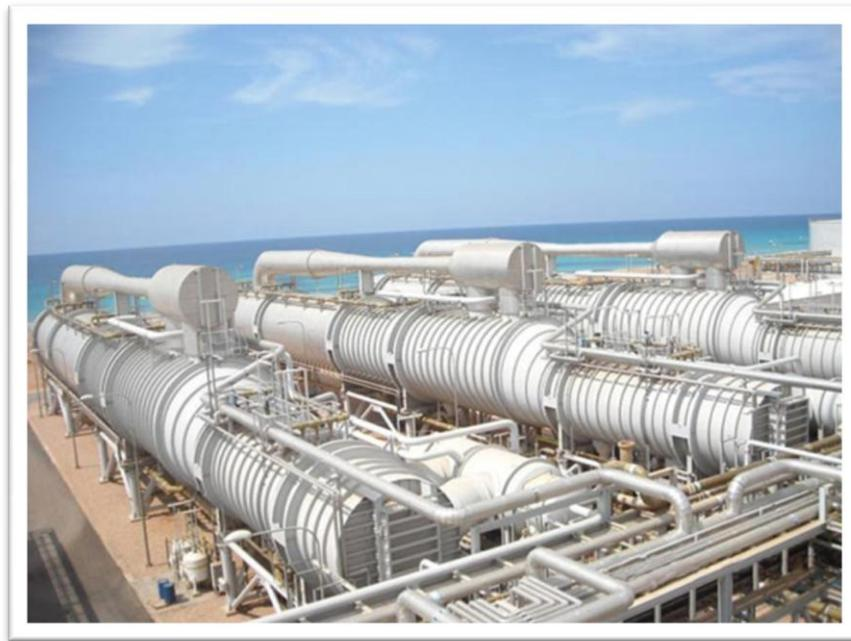
Figure (29) : Dessalement d'eau de mer par système multi-effets en Libye [14]
