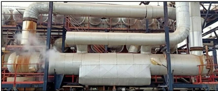
**Figure (13) : Réchauffeur de la section de dessalement**
