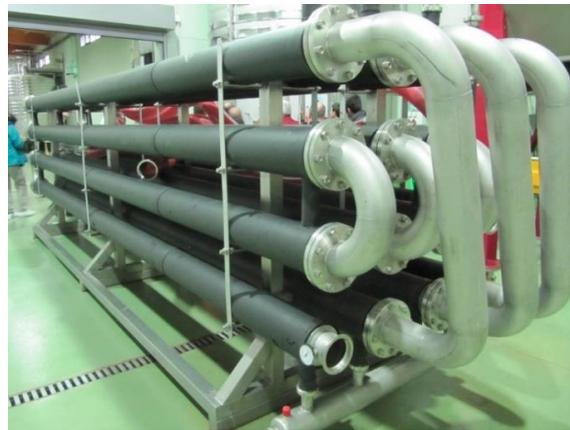
**Figure 1.11** :Schéma et photographie d'un échangeur à double tubes.
