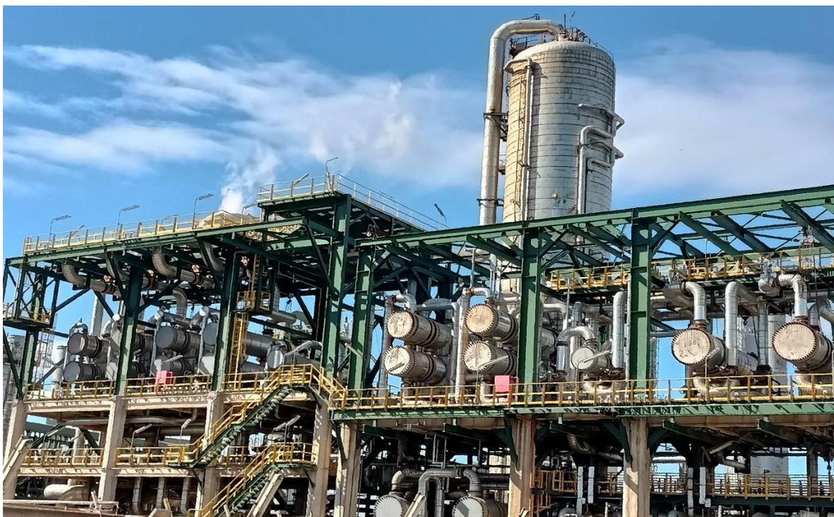
**Figure 1.6** : les échangeurs de chaleur dans une installation industrielle de Sonatrach - Skikda
