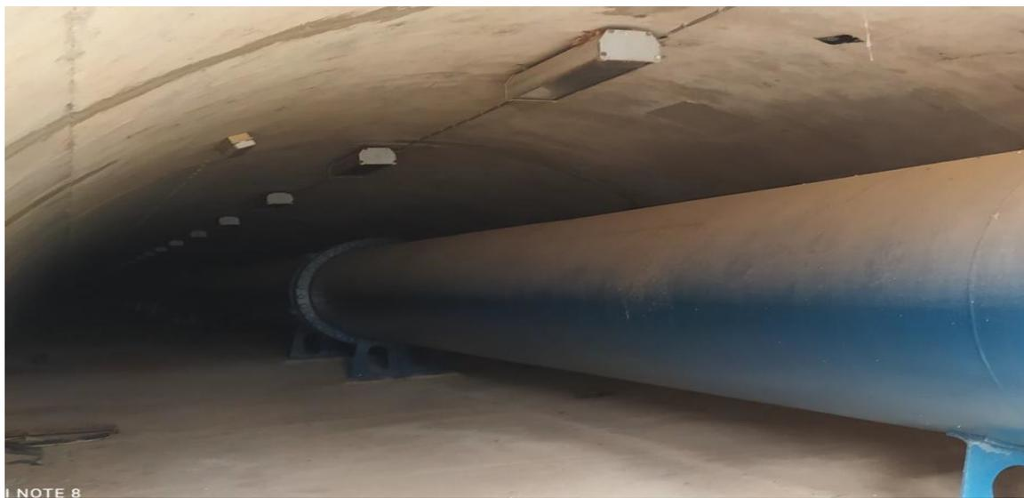
**Figure (I.1):** Conduite principale sortante du Barrage.
