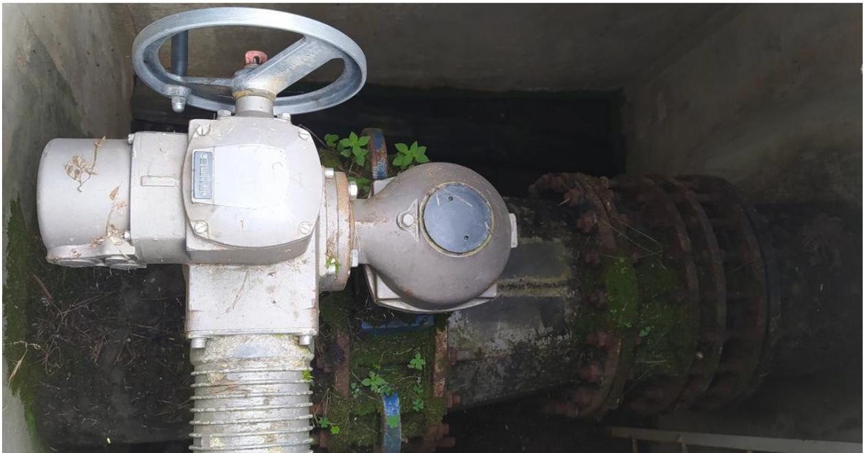
**Figure (I.4):** Vanne à l'extrémité de la conduite en cuirve
