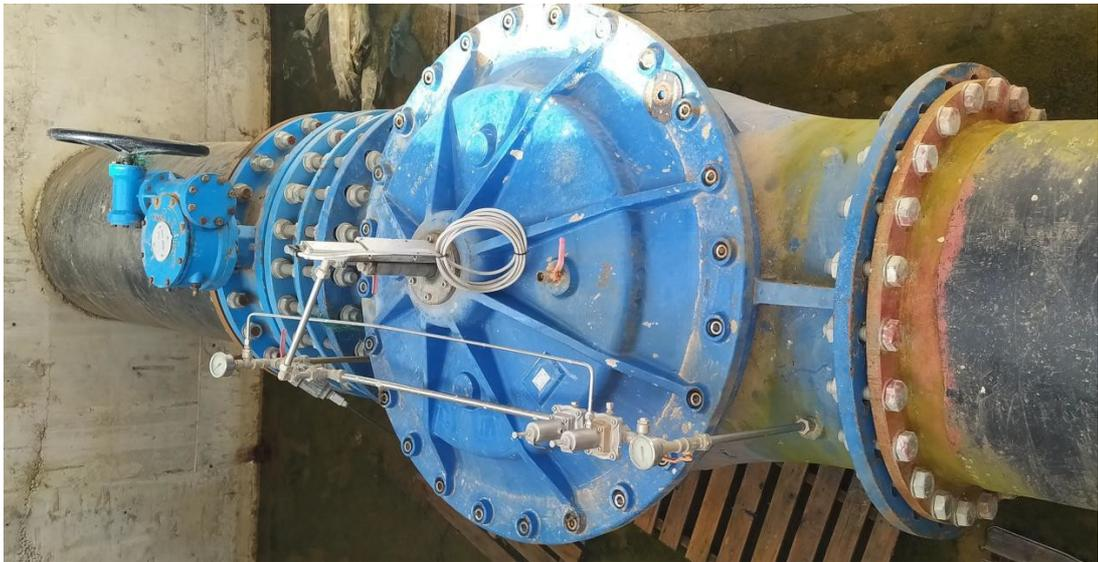
**Figure (I.5):** Vanne à l'extrémité de la conduite en PRV. **La source:** Google 2022.
