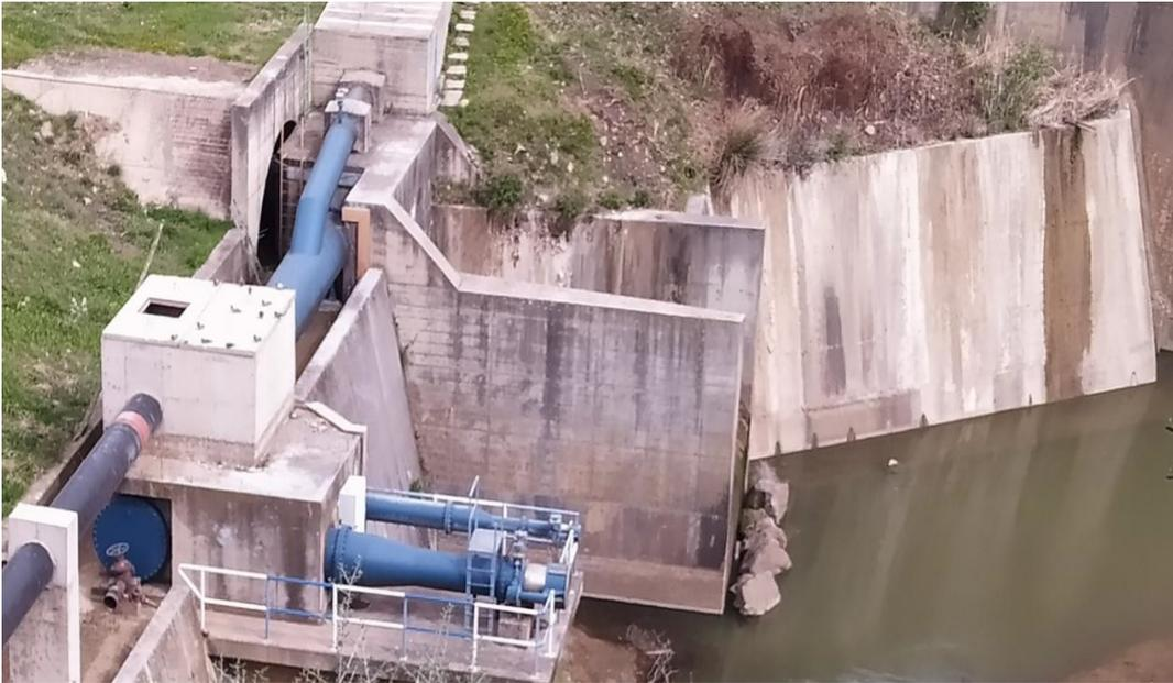
**Figure I.2:** Photo des points de jonction des conduites secondaires à la conduite principale
