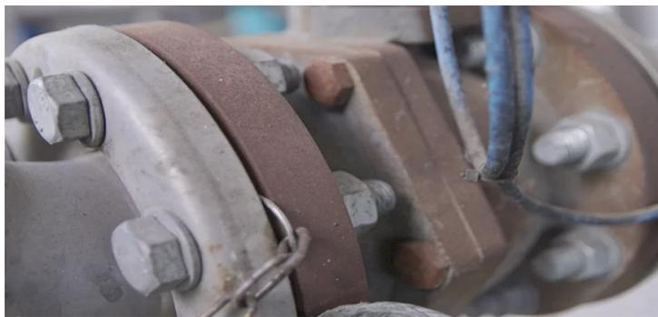
Figure I.13 Phénomène de corrosion
